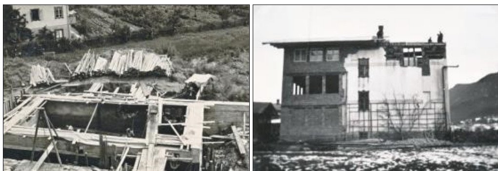
Rohbau 1955, Keller und Westansicht, das alte Schulhaus verschwindet
